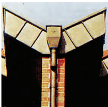
ΣΧ.4.2.γ Τα εμφανή δίκτυα αποχέτευσης βροχίνων νερών, όταν είναι κατασκευασμένα από χαλκό, διακοσμούν τις όψεις των κτιρίων.
