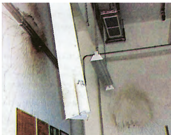
ΣΧ.10.4.δ Τα αποτελέσματα της κατάσβεσης είναι αποκαλυπτικά για το τι θα συνέβαινε αν παρέμενε άνθρωπος μέσα στο χώρο. Πέρα από το ξεκρέμασμα του φωτιστικού, οι τοίχοι έχουν “καεί” από το \text{CO}_2 .
