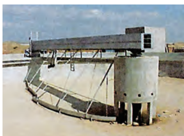
ΣΧ.5.3.3.γ Κυκλική δεξαμενή καθίζησης και περιστρεφόμενος μηχανισμός απόξεσης του πυθμένα.
