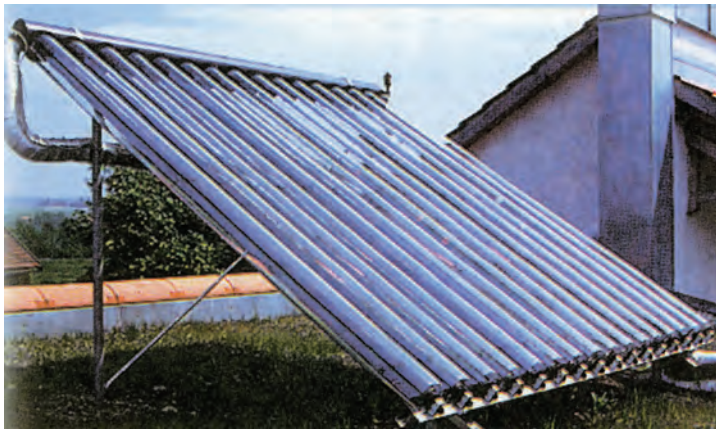
ΦΩΤ. 2.17.2.ε Ηλιακός συλλέκτης με σωλήνες κενού. Στα ηλιακά συστήματα κλειστού κυκλώματος υπάρχει η δυνατότητα τοποθέτησης των συλλεκτών σε πολλές θέσεις που δεν δημιουργεί αισθητικά προβλήματα η παρουσία τους.
