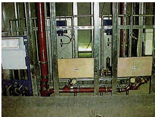
ΦΩΤ. 3.4.β Εγκαταστάσεις ύδρευσης-αποχέτευσης στηριζόμενες σε διαχωριστικό πάνελ κτιρίου. Οι σωλήνες ύδρευσης είναι από γαλβανισμένους σιδηροσωλήνες ενώ αυτοί της αποχέτευσης μαντεμένιοι.
