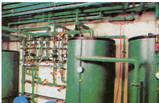
ΣΧ.8.5.1.α Υδραυλική εγκατάσταση κατασκευασμένη με αυτοσυγκολλούμενους πλαστικούς σωλήνες.
