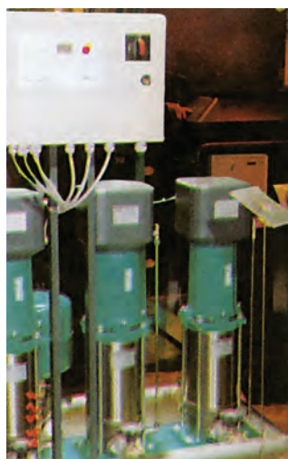
ΣΧ.9.2.3.α Αντλίες με ενσωματωμένο μετατροπέα συχνότητας.
