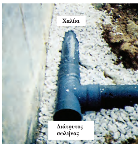
ΣΧ.4.11.β Τοποθέτηση σωλήνα αποστράγγισης υπογείων υδάτων.
