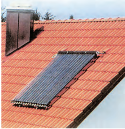
ΦΩΤ. 2.17.2.δ Ηλιακοί συλλέκτες τοποθετημένοι με ιδιαίτερη προσοχή σε κεραμοσκεπή οικοδομής, ώστε να μη ξεχωρίζουν πολύ από τα κεραμίδια.
