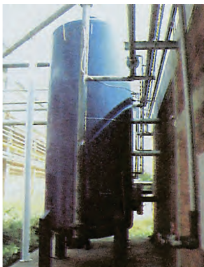
ΣΧ.9.2.2.β Δοχείο βιομηχανικού πιεστικού συγκροτήματος, χωρητικότητας 16m^3 , που λειτουργεί με πεπιεσμένο αέρα. Το δοχείο αυτό καλύπτει μικρές καταναλώσεις, χωρίς να ξεκινά η λειτουργία της αντλίας.
