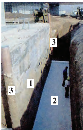
ΣΧ.4.9.2.γ Περιμετρική τάφρος αποστράγγισης υπογείων υδάτων. Διακρίνονται ο τοίχος του υπογείου (1), το νάλον που σκεπάζει το χαλίκι (2) και ο σωλήνας μέσα στον οποίο τοποθετείται η αντλία απομάκρυνσης των νερών (3).
