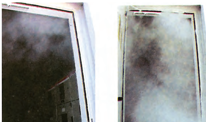
ΣΧ.10.4.γ Αριστερά μόλις έχει αρχίσει η εκκένωση διοξειδίου του άνθρακα πάνω από τους ηλεκτρικούς πίνακες. Δεξιά, το \text{CO}_2 έχει κατακλύσει όλο τον χώρο. Οι συνθήκες είναι αποπνικτικές και ιδιαίτερα επικίνδυνες.
