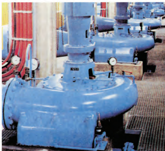
ΣΧ.6.3.α Αντλιοστάσιο ύδρευσης πόλης.
