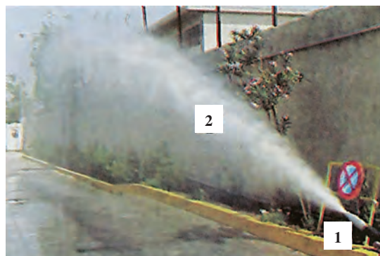
ΣΧ. 10.5.α Ο τακτικός έλεγχος καλής λειτουργίας διασφαλίζει την ετοιμότητα ενός μόνιμου πυροσβεστικού δικτύου.
