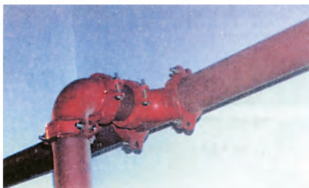
ΣΧ.8.2.2.ι Λυόμενη σύνδεση σε δίκτυο πυρόσβεσης.
