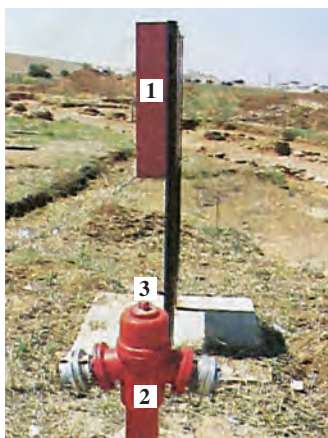
ΣΧ. 10.2.2.β Δίδυμο πυροσβεστικό υδροστόμιο σε υπαίθριο χώρο. Διακρίνονται η πυροσβεστική φωλιά που περιέχει τη μάνικα (1), ο δίδυμος κρουνός (2) και ο διακόπτης ανοίγματος του νερού (3).
