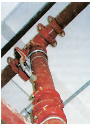
ΣΧ.10.3.1.β Εύκαμπτο λυόμενο δίκτυο πυρόσβεσης, κατασκευασμένο από βαμμένους σιδηροσωλήνες. Οι ενώσεις των σωλήνων γίνονται με ειδικούς συνδέσμους. Πρόκειται για νεότερης τεχνολογίας δίκτυο, το οποίο αντέχει πολύ στους σεισμούς.
