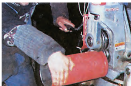
ΣΧ.10.3.1.γ Για τα λυόμενα δίκτυα απαιτείται η κατασκευή ενός αυλακιού, στα άκρα των σωλήνων. Στο αυλάκι αυτό, το οποίο γίνεται με τη βοήθεια της εικονιζόμενης μηχανής, “κουμπώνει” το ειδικό εξάρτημα σύνδεσής τους. Επισημαίνουμε τα προστατευτικά μανίκια που φορά ο τεχνίτης καθώς και την απουσία δακτυλιδιών και ρολογιού, προκειμένου να αποφευχθεί το ενδεχόμενο ατυχήματος, καθώς περιστρέφεται ο σωλήνας.
